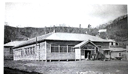
明治40年頃の校舎 (明治39年7月に昆布森村17番地に改築移転)
